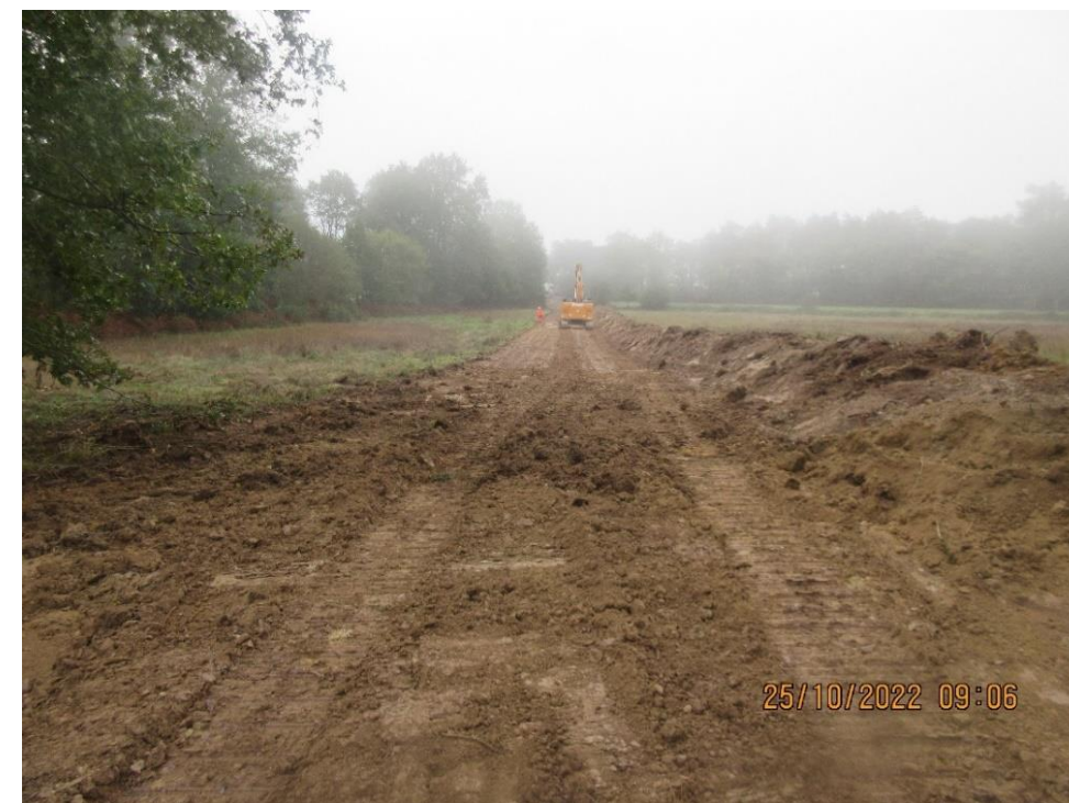
Figure 24 : Aménagement de la piste de travail de 15 m hors zone humide sur la Tranche 3
