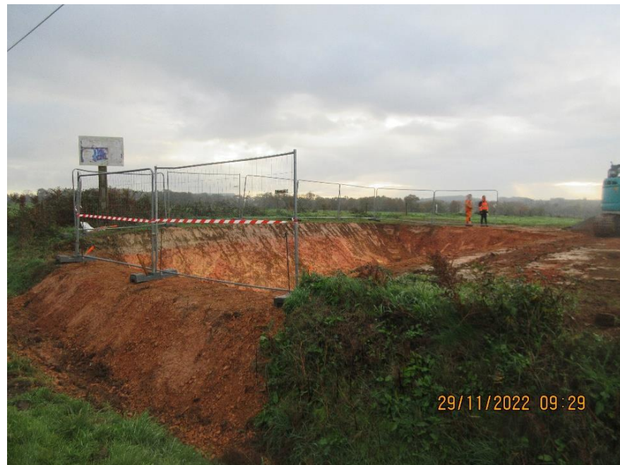
Figure 29 : Fosse du forage sous voirie
