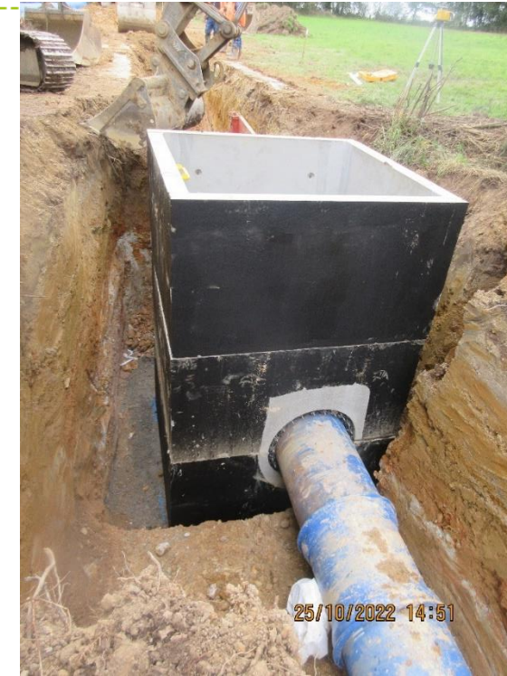
Figure 5 : Pose d'une vanne de sectionnement en Tranche 3
