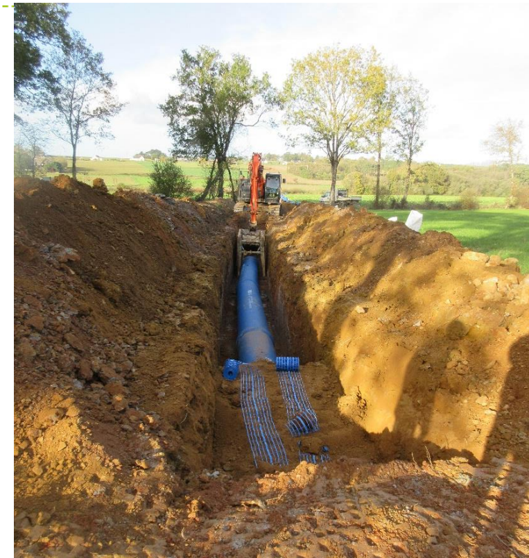
Figure 27 : Pose du grillage avertisseur de couleur bleue
