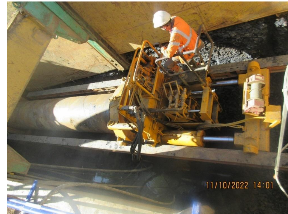
Figure 30 : Pose de la canalisation en forage
