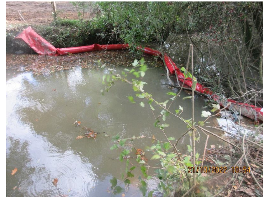
Figure 37 : Exemple de mise en œuvre de batardeau souple sur les travaux en Tranche 3
