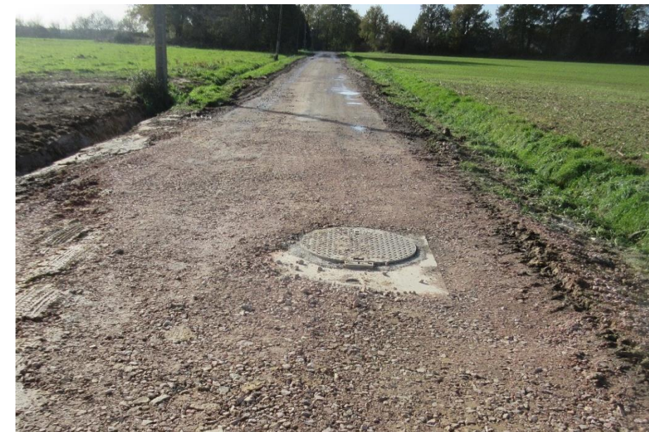
Figure 7 : Positionnement d'un regard de vidange
