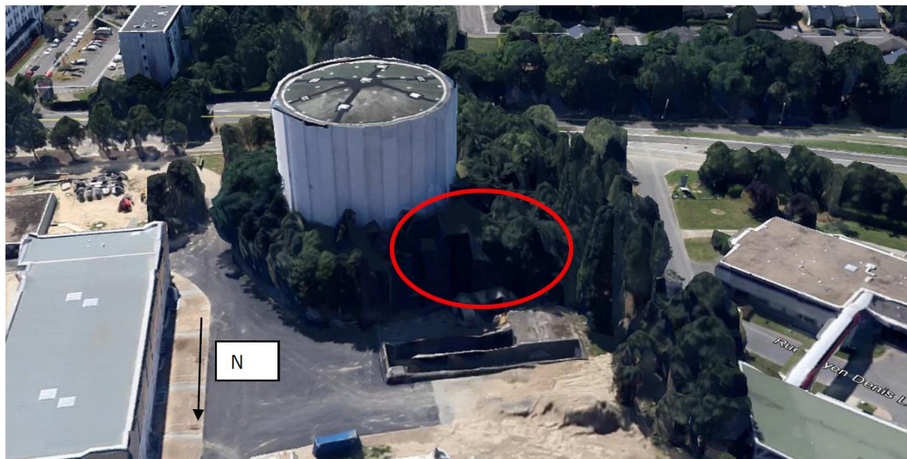
Figure 10 : Emplacement de la future station de pompage
