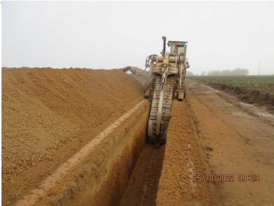
Figure 25 : Déblaiement à l'aide d'une trancheuse en Tranche 3
