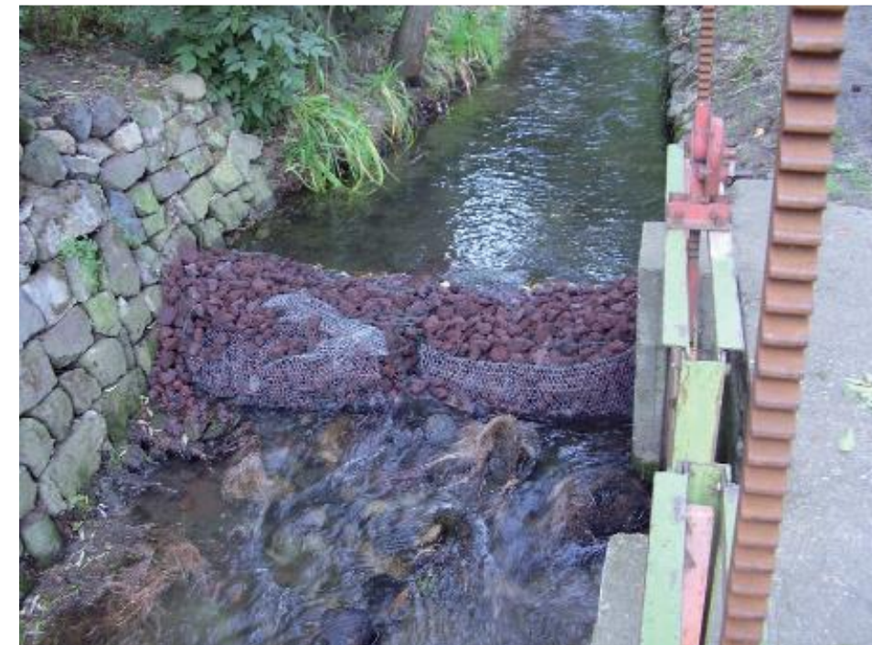
Figure 34 : Exemple de filtre rustique à pouzzolane pour une intervention en rivière de courte durée
