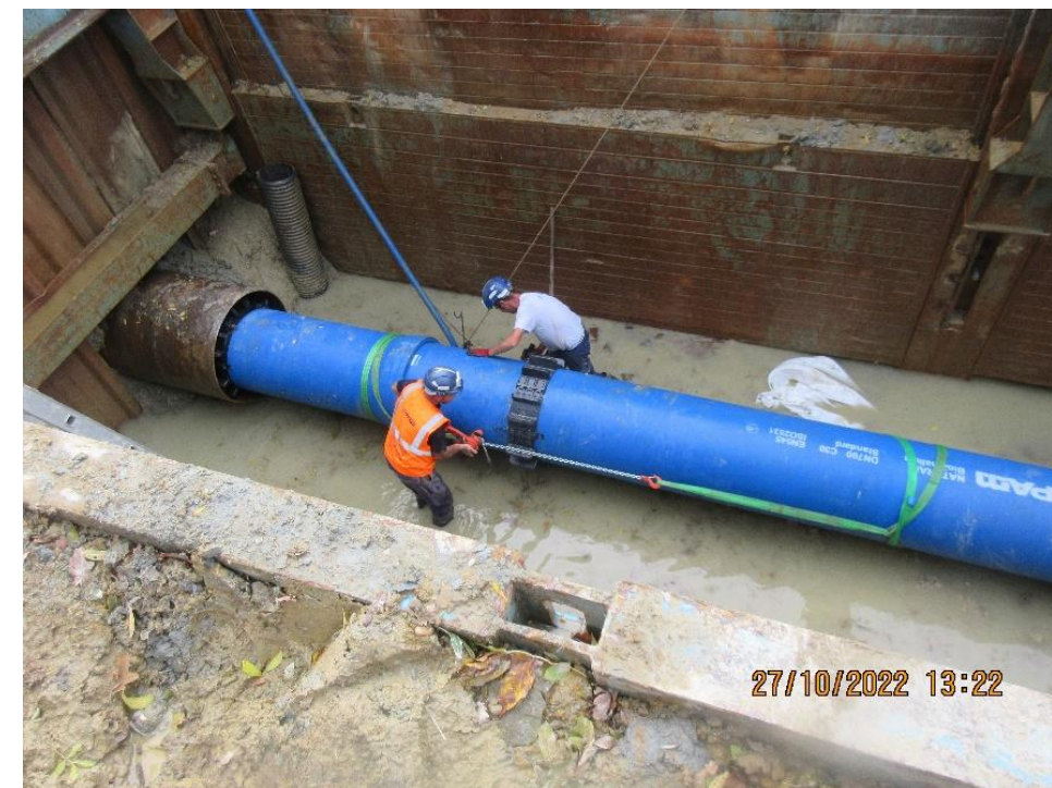
Figure 31 : Pose de la canalisation en forage
