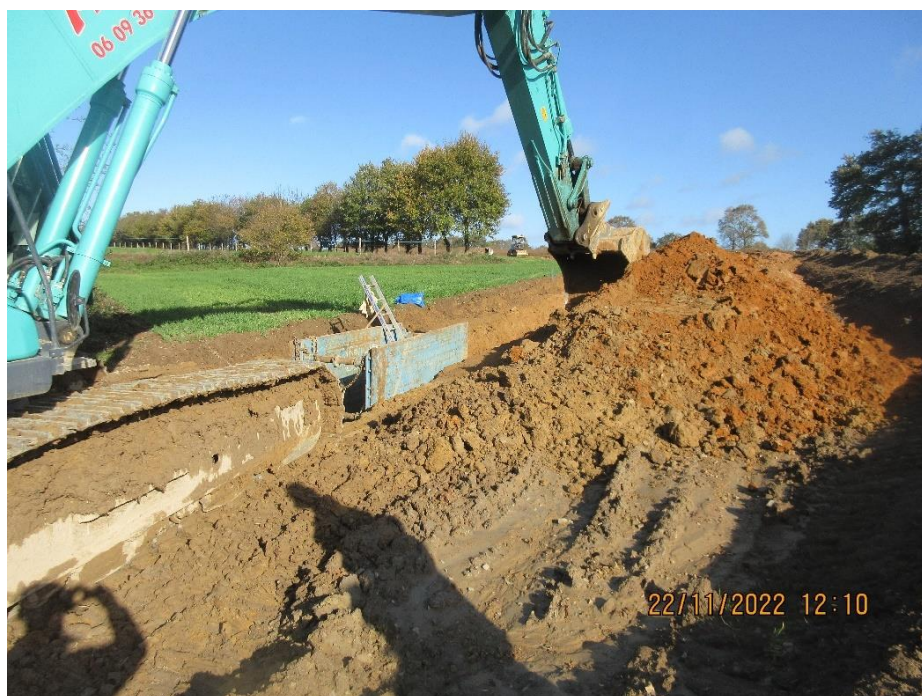
Figure 26 : Utilisation de la pelle mécanique pour le déblaiement et pose de la canalisation « avec blindage de sécurité » en tranchée ouverte en Tranche 3
