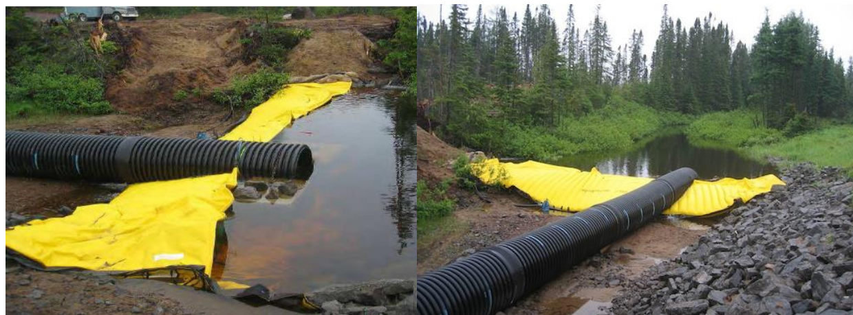
Figure 36 : Exemple de mise en œuvre de batardeau souple
