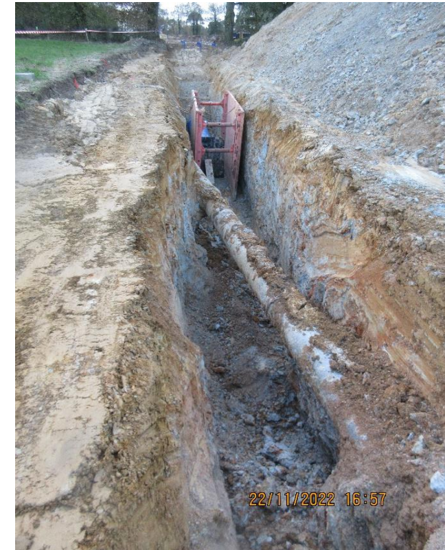
Figure 28 : Rencontre d'une canalisation sur le tracé de l'AVA
